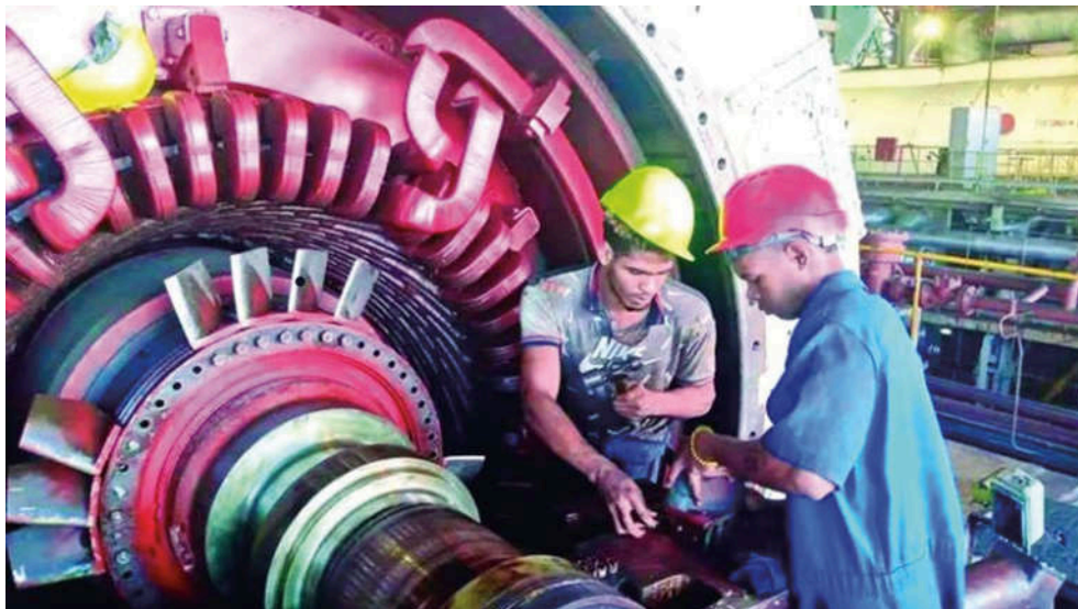
Trabajadores eléctricos cubanos reparan equipos de generación de energía para restablecer el suministro eléctrico tras un apagón. Foto: Prensa Latina.
