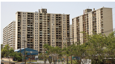
Las Gladiolas complejo de vivienda pública en Hato Rey, San Juan, antes de su demolición en 2011
